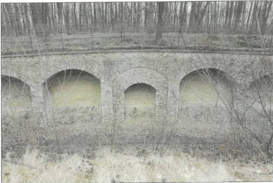
Vue prise du dessus de la caponnière de tête.
