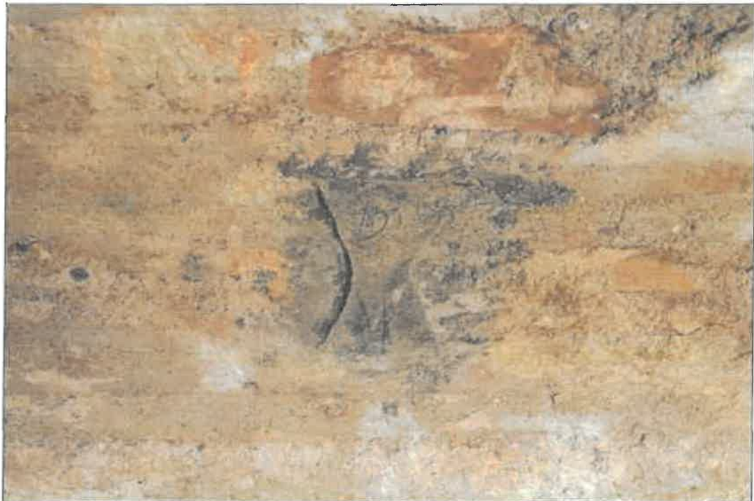
Témoin sous la voûte d'un caveau.
