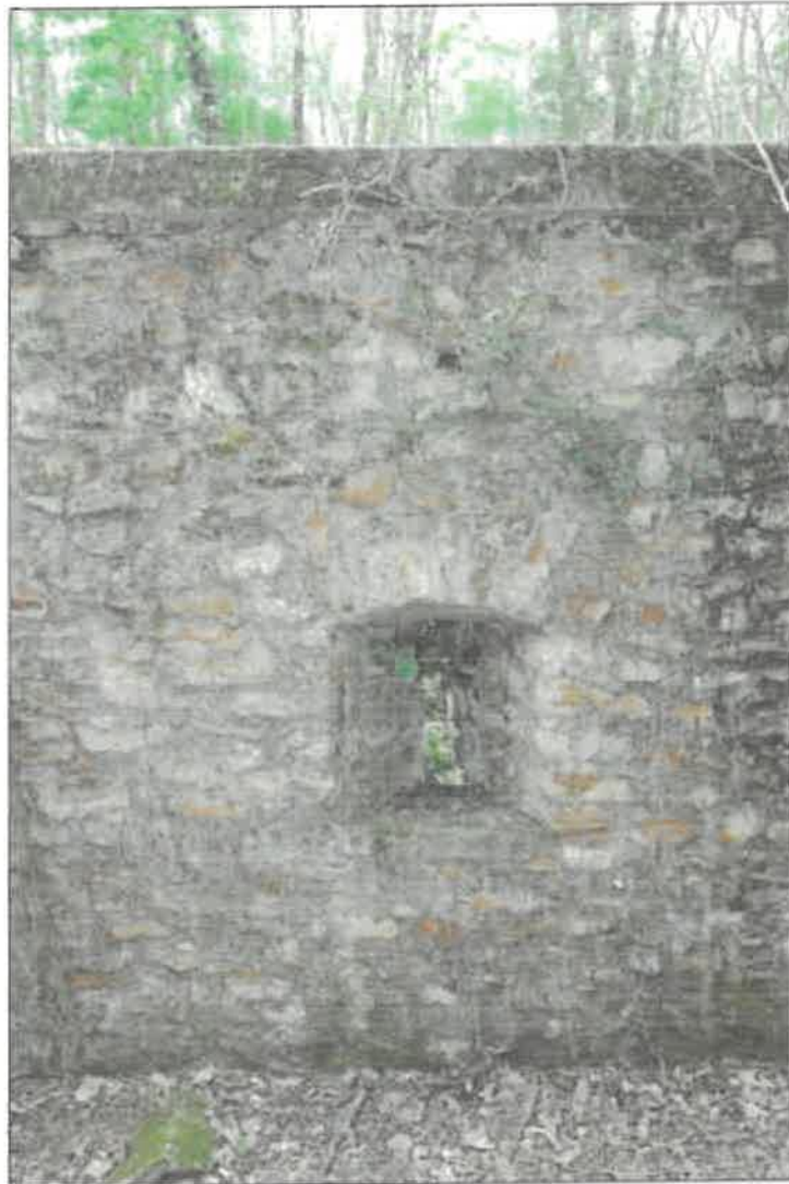
Vue du mur d'escarpe du côté du chemin de ronde. Il s'agit de la partie détachée avec la présence d'un créneau de tir.
